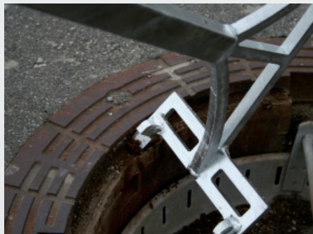
integrierte Schaber zum Reinigen des Führungsrahmens des Kanalschachtes
