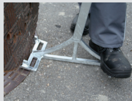
Schachtdeckel wird aus der Arretierung gehoben
